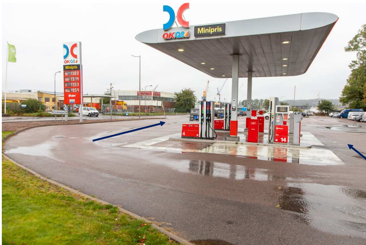
Figur 4 Drivmedelstation med tak. I höjd med pump 14 finns en lågpunkt där vatten kan ansamlas. Pilar visar ungefär var lokala lågpunkter, som avleder dagvatten till brunnar, finns. Foto: Lina Ekholm, Kretslopp och vatten
