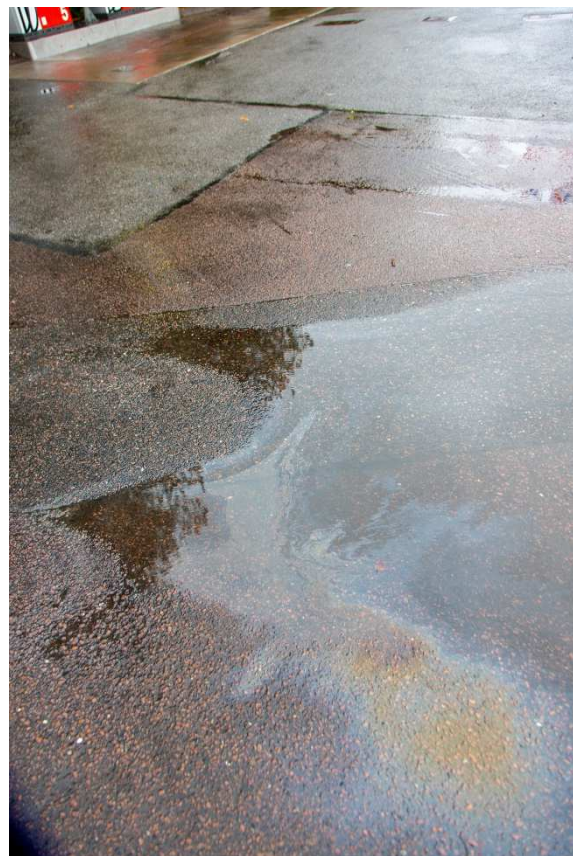
Figur 6 Oljeförorening. Troligen från spillzonen vid pump 5 och 7. Foto: Lina Ekholm, Kretslopp och vatten
