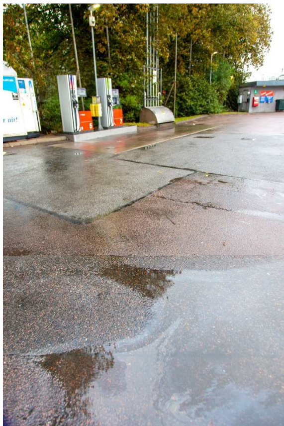
Figur 6 Oljeförorening. Troligen från spillzonen vid pump 5 och 7. Foto: Lina Ekholm, Kretslopp och vatten
